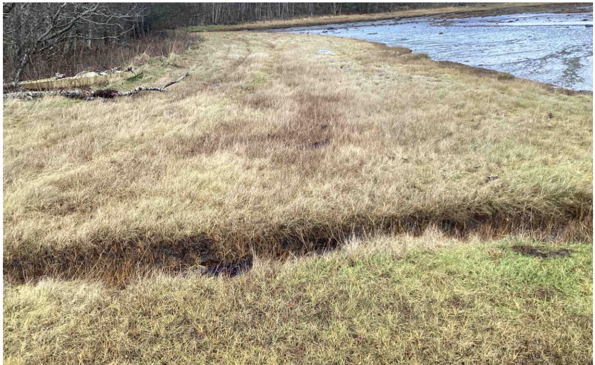
Figur 51. Strandenga, særlig i vest, har preg av kjørespor. Her har det vært brukt tunge kjøretøy i flere tiår basert på flyfoto.
