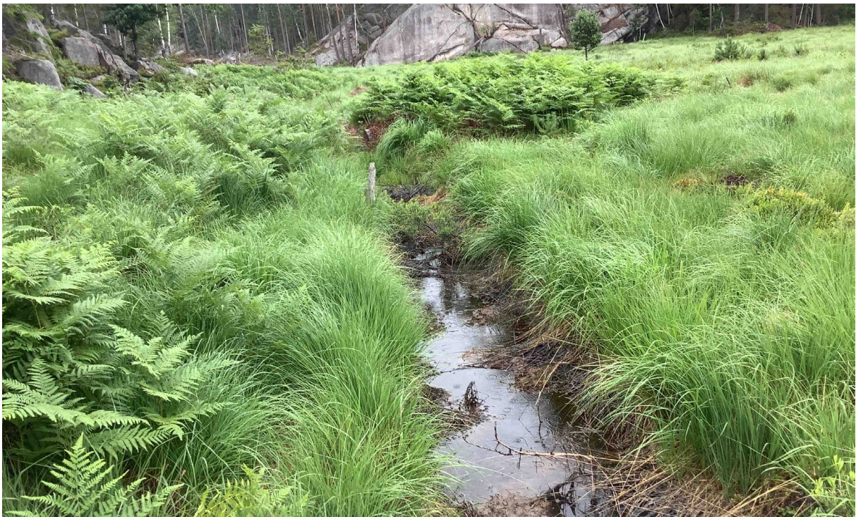
Bilde 10. Ronsmyra er kraftig preget av grøfting. Det er gjort restaureringstiltak med hogst av trær og tetting av grøfting, men noen grøfter er fortsatt åpne.
